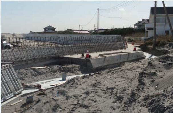
鹿島海岸堤防嵩上工事(積算・工事監督補助業務)
