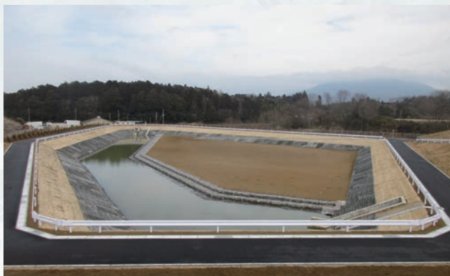
しもつま桜塚工業団地(積算・工事監督補助業務)
