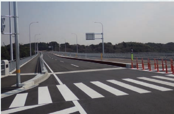
H29年3月開通 都市計画道路宮中佐田線(積算・工事監督補助業務)
