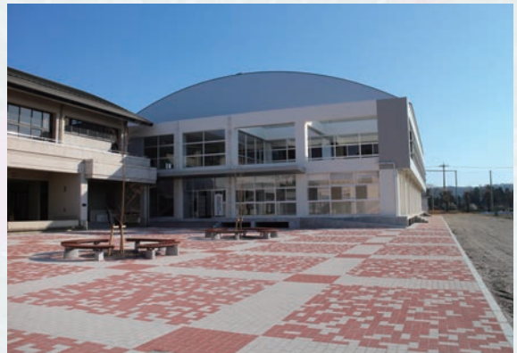
城里町立桂中学校屋内運動場(実施設計・工事監理業務)
