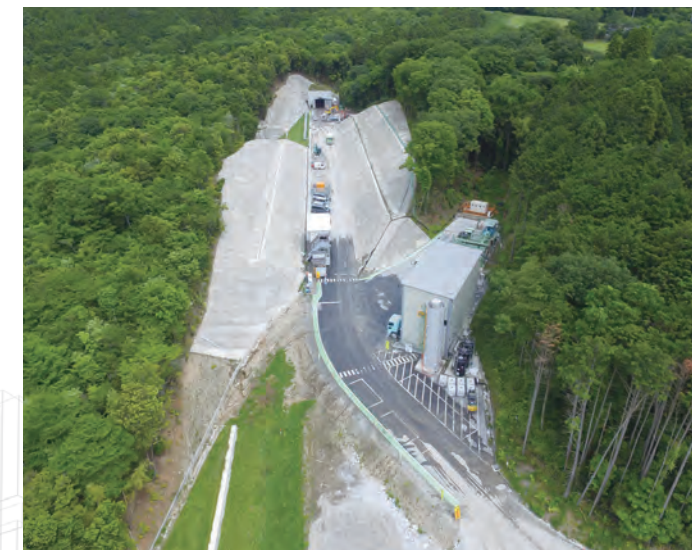
トンネル工事（上曽トンネル） （積算・工事監督補助業務：筑西土木事務所、土浦土木事務所）
