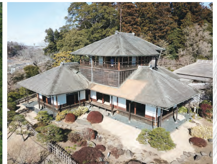
偕楽園公園好文亭（楽寿楼）耐震補強工事 （工事監督補助業務：水戸土木事務所）
