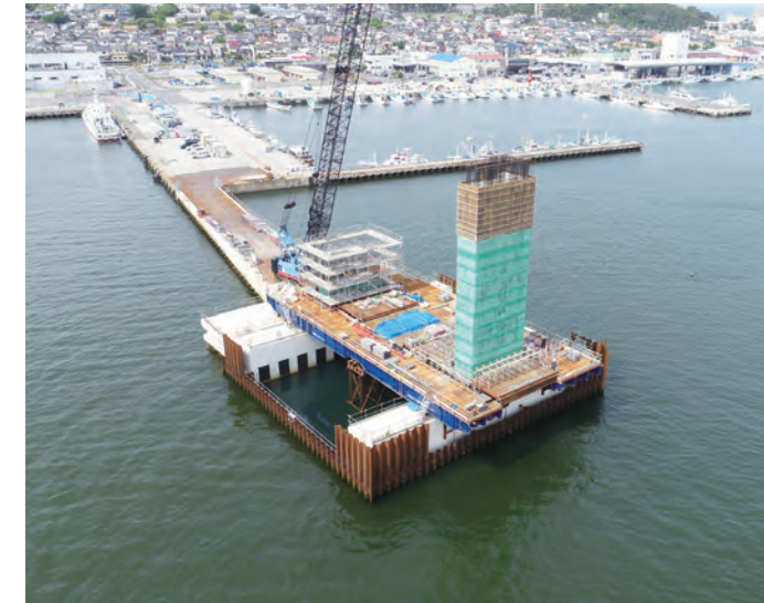
水門上部工事 （積算・工事監督補助業務：茨城港湾事務所大洗港区事業所）
