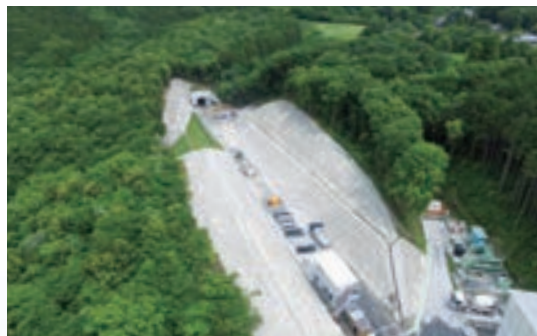
上曽トンネル (積算・工事監督補助業務：筑西土木事務所、土浦土木事務所)
