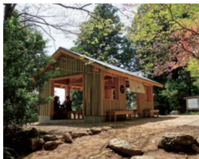
筑波山中四阿（弁慶茶屋跡）建築工事 (設計・積算・工事監理業務：茨城県生活環境部)
