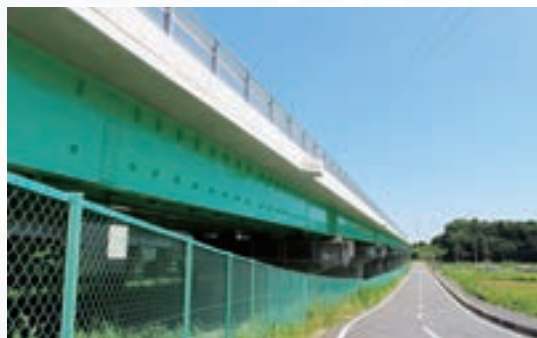
赤法花高架橋 (工事監督補助業務：土浦土木事務所)
