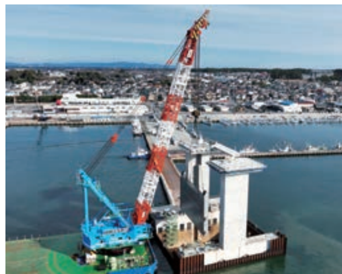
水門ゲート据付工事 (積算・工事監督補助業務：茨城港湾事務所大洗港区事業所)
