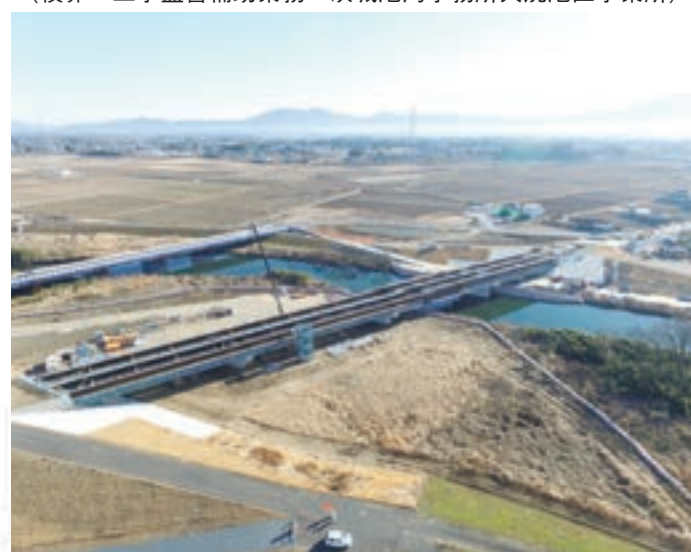
橋梁上部工工事（養蚕橋） (積算・工事監督補助業務：茨城県筑西土木事務所)
