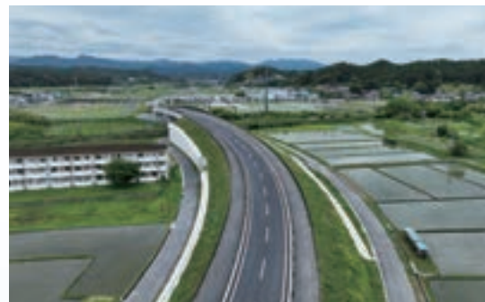
北町関本中線 (積算業務：高萩工事事務所)
