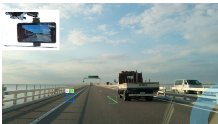
区画線の状況調査
