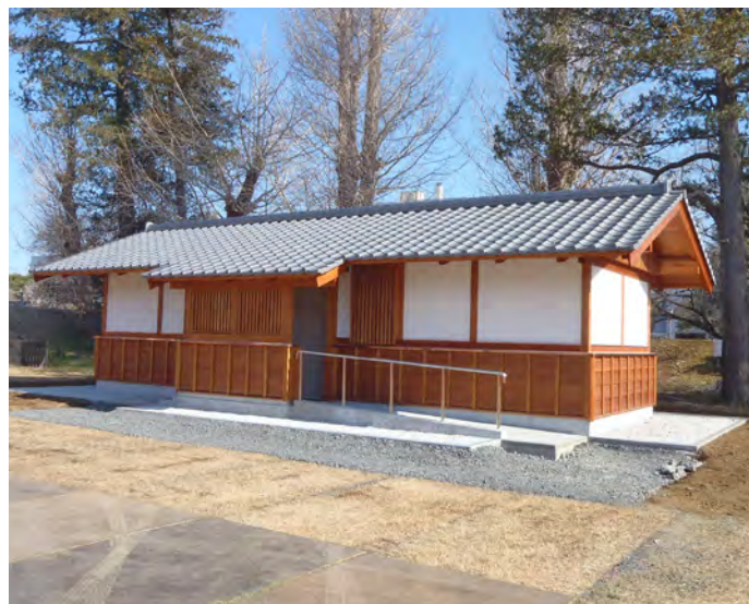
弘道館公園公衆トイレ建築工事 (設計・積算・工事監理業務：茨城県水戸土木事務所)
