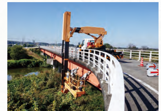
水神橋 （橋梁定期点検業務：土浦市）
