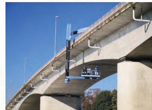
常総きぬ大橋 （橋梁定期点検業務：常総市）
