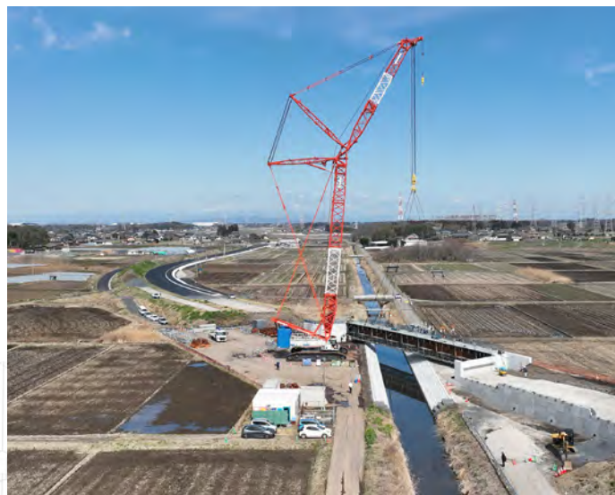
新天神橋(国道354号バイパス) 橋梁上部工架設工事 (積算・工事監督補助業務：茨城県境工事事務所)
