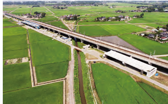
柳島高架橋 橋梁上部・下部工事 （積算・工事監督補助業務：土浦土木事務所）
