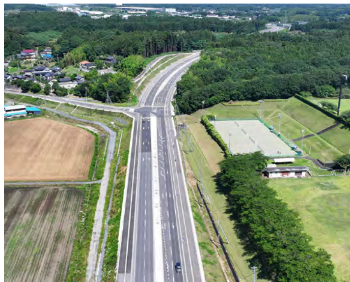
主要地方道大洗友部線 道路改良舗装工事 (積算・工事監督補助業務：茨城県水戸土木事務所)
